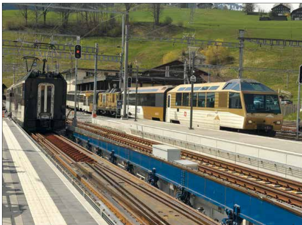
Entrée en gare à Zweisimmen d'une circulation commerciale régulière. Au premier plan, la voie 6 (bientôt équipée) et au second la voie 7, déjà pourvue de sa rampe de changement d'écartement. La démonstration est effectuée avec une demi-9000 (30 avril 2019).
